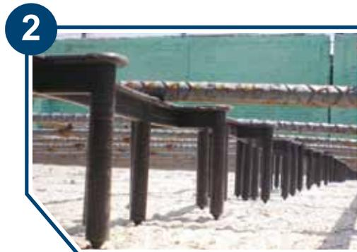
3. Cada línea de separación se ubicará a una distancia de entre 1 y 1.5 m. dependiendo del peso del armado de varillas.
